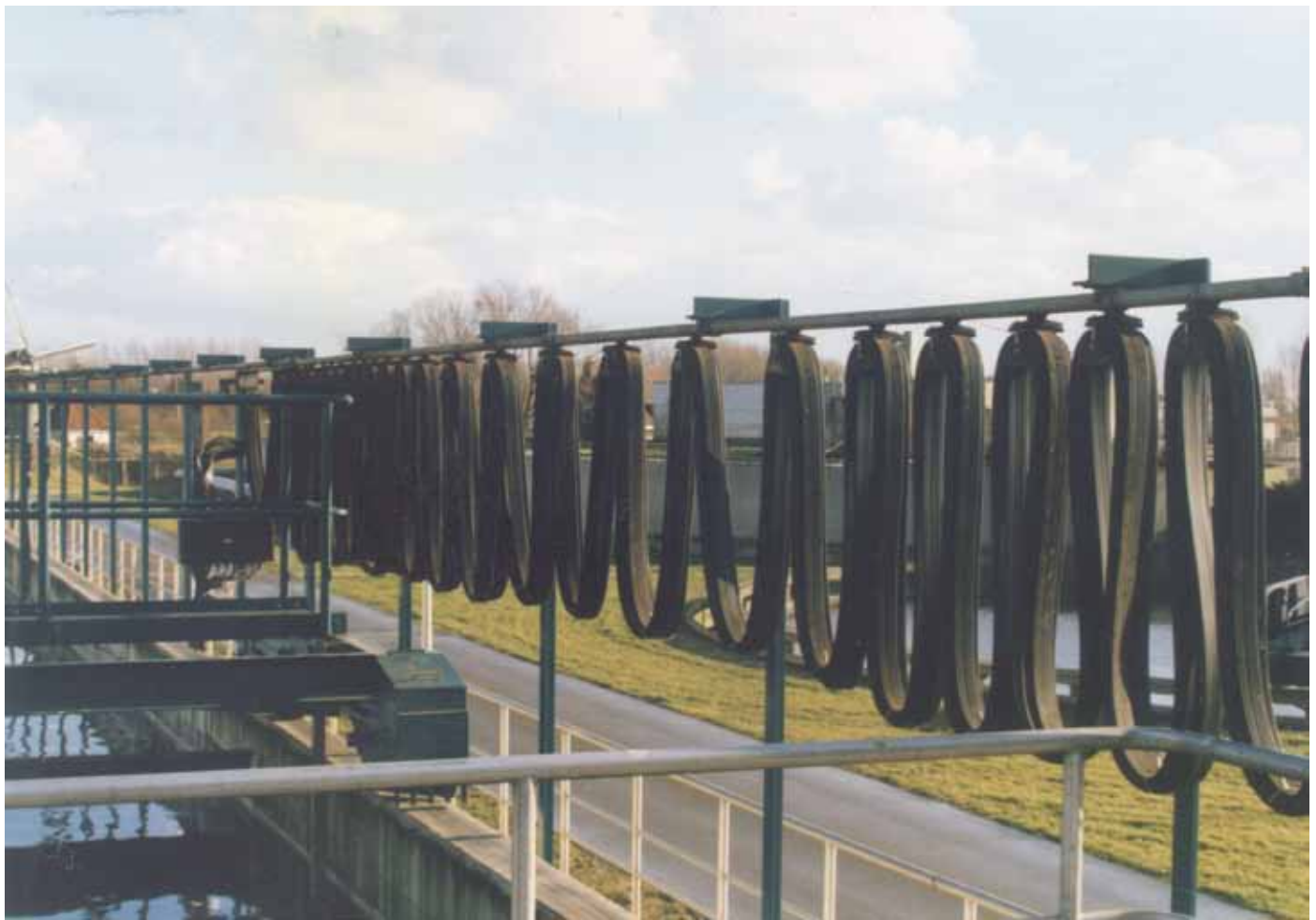
AKAPP-система перемещения плоских электрокабелей на станции водоочистки
