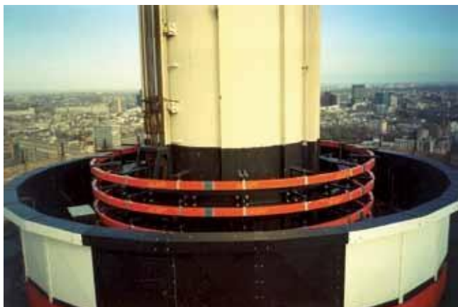
4 замкнутых изогнутых токоподвода для вращающегося лифта
